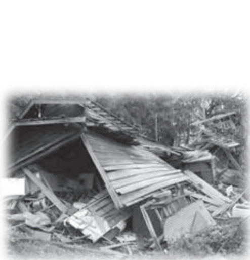
被災状況（八街市）
